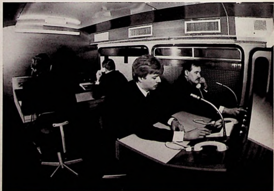
Bild 3. Fernmelderaum des ELW 3 mit dem „Kommandotisch“ (hinten) und dem „Sichtertisch“ (vorne)
